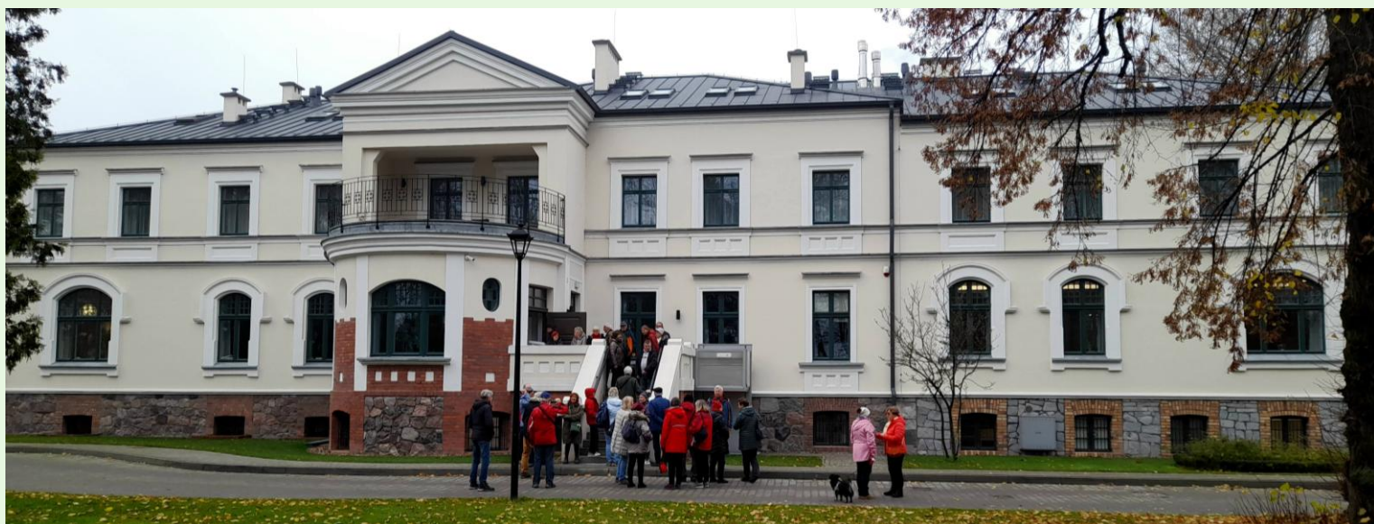
Skrzynki - piętrowy, eklektyczny dwór zbudowany w II połowie XIX wieku przez niemiecką rodzinę Ifflandów, która zarządzała folwarkiem do 1945 roku
